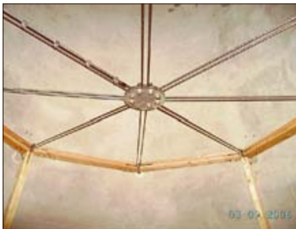
La struttura di corde d'acciaio all'interno della «pina»
